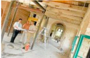
Bernhard Wilhelm Bücken, Hans-Gerd Schnieder und Martin Varwick gestern in der Schlossmühle, die zurzeit völlig saniert wird. Mitte nächsten Jahres soll dort wieder ein Restaurant eröffnet werden. Foto: (dru)
